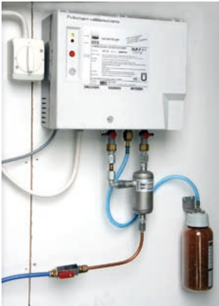
Öljynerottimen (PEK) ja säiliöiden vuodonilmaisujärjestelmän (kaksoisvaippasäiliön välitila) hälyttimet.
