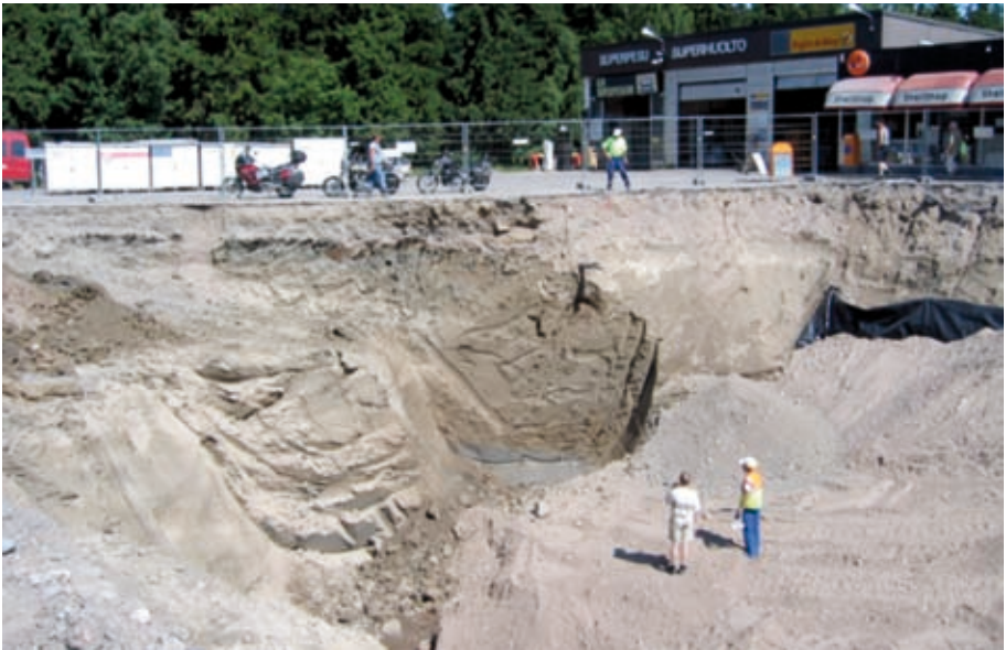
Kuvassa polttonesteiden jakeluaseman pilaantuneen maan kunnostustyömaa.
