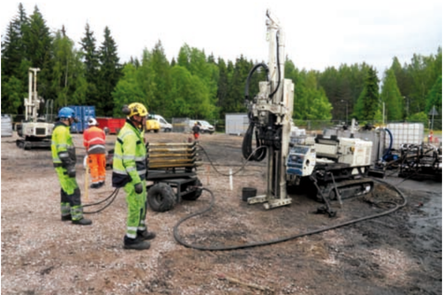
Kuvassa Insitu-kunnostus polttonesteiden jakeluasematontilla (maanpinta on värjäytynyt maaperään ruiskutettavasta aktiivihilestä).
