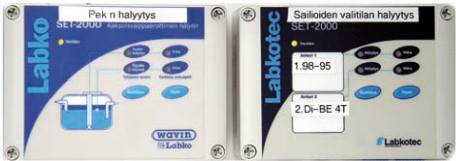
Öljynerottimen (PEK) ja säiliöiden vuodonilmaisujärjestelmän (kaksoisvaippasäiliön välitila) hälyttimet.
