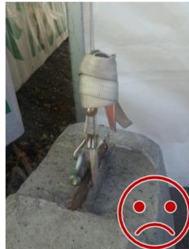
Kuva 8. Sakkeli löytyy, mutta tätä ei ole käytetty kiinnitykseen. Koukku irtoaa rakenteen jousaessa.
