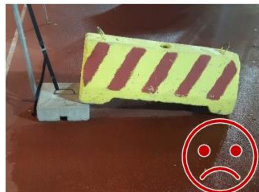
Kuva 4. Kuormallinen kitkalukko on heikko. Pienempi paino saattaa liikkua, jolloin suurempi paino putoaa aiheuttaen vaaraa.
