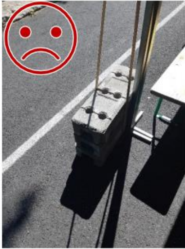
Kuva 5. Liina ei ole lukittu painoihin. Painot ja liina saattavat liikkua siten, että irtoavat toisistaan.
