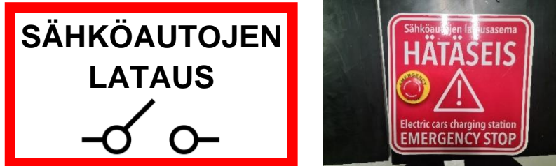
Kuva 1. Esimerkkejä opasteista, joilla voidaan osoittaa keskitetty virransyötön katkaisupaikka.
